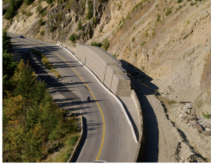
Terraplenes contra el desprendimiento de rocas y deslizamiento de tierras
