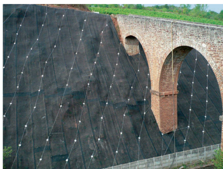
Soil Nailing y protección de la superficie
